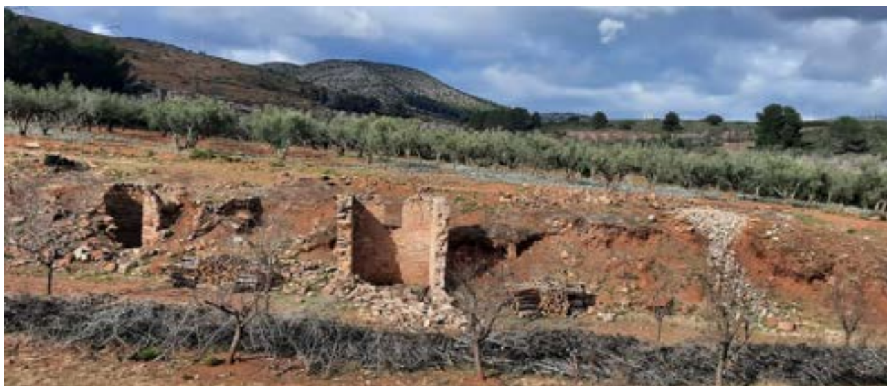
Conjunto de caleras del Rodeno. Febrero 2025
