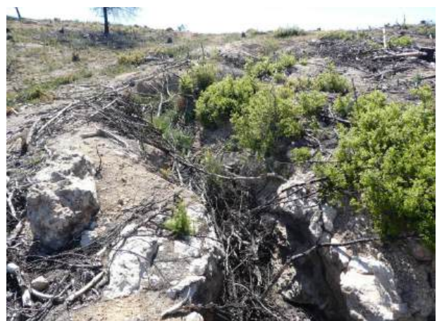
Penoso estado de las trincheras del Puntalico
