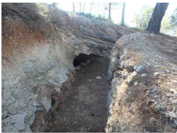
Tramo de trinchera parcialmente restaurado
