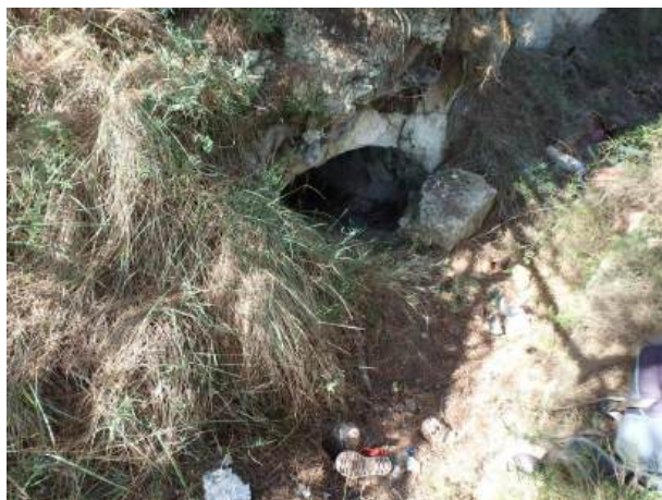
Refugio Aguas Blancas 2, boca 1
