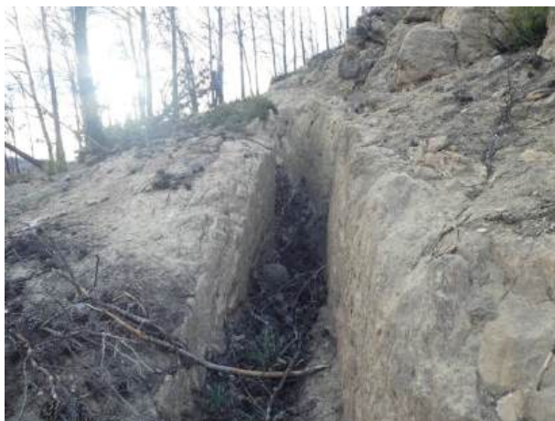
Tramo de trinchera en aceptable estado
