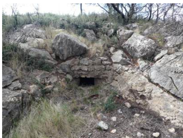
Nido de ametralladoras del Camino de la Chana
