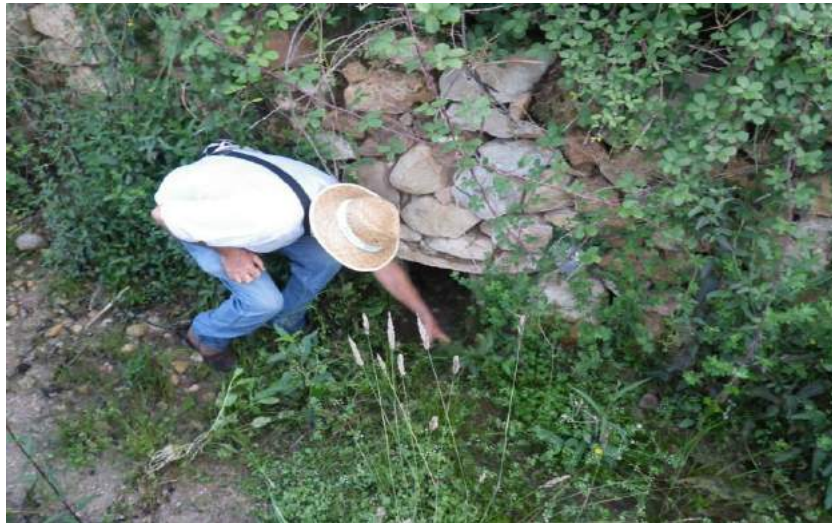
"Caño" por el que surge el agua
