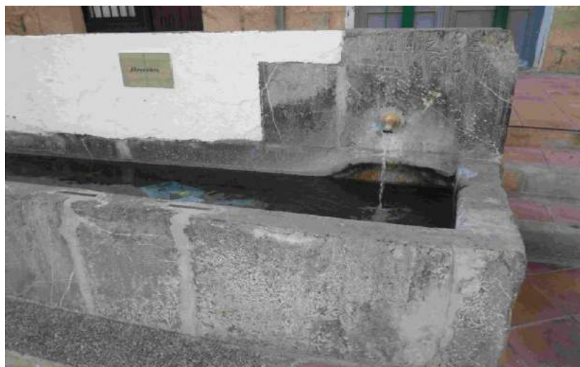
Fuente del Abrevadero
