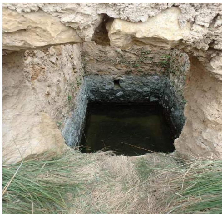
Pozo en la Masía de los Chaneros
