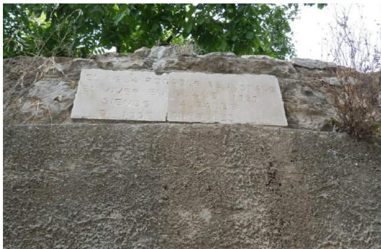
Placa en el depósito de aguas de la Teja, tal vez el primero de Viver
