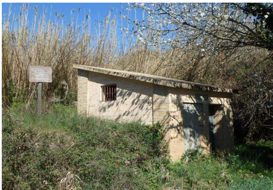
Caseta donde se captan y conducen las aguas de la Chorrera
