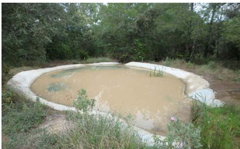
Navajo de construcción moderna, con lecho de hormigón. Este es el de Benabal o la Molinera
