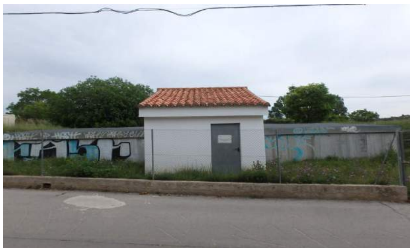
Depósito de aguas de Mosén Villar, que almacena las aguas de San Miguel
