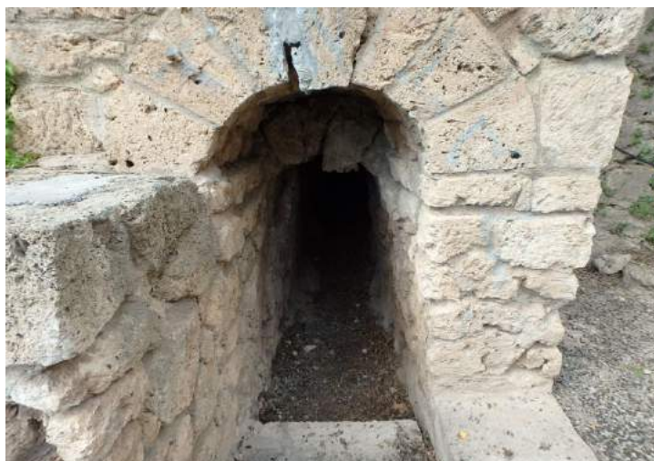
Túnel de la Floresta, entrada
