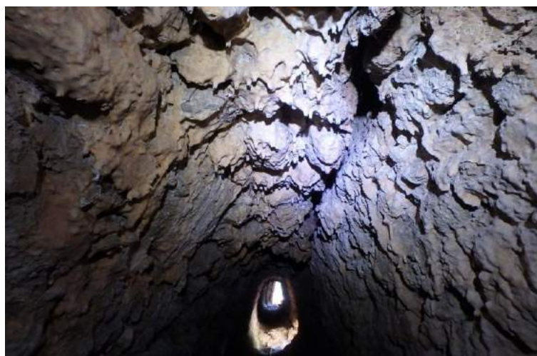
Túnel de la Floresta, interior
