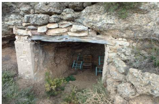
Covacho caseta de la Hoya Cándido
