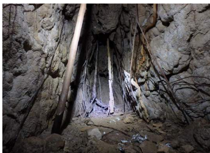
Túnel de la Floresta, final con raíces de los árboles
