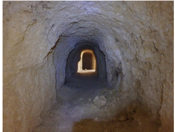
Refugio Aguas Blancas 1, interior
