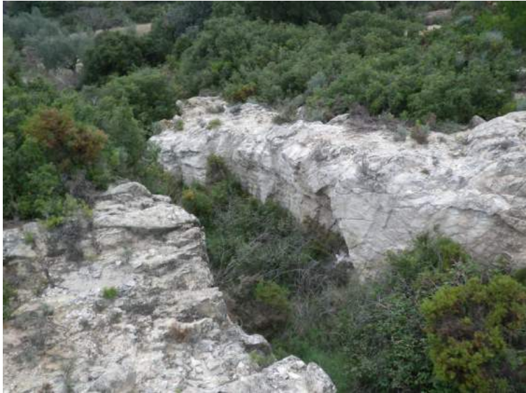
Hundimiento de El Sumergido, detalles de las fracturas
