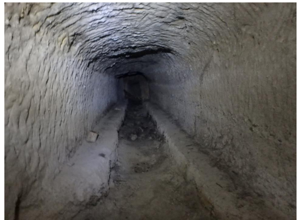
Refugio Aguas Blancas 2, interior
