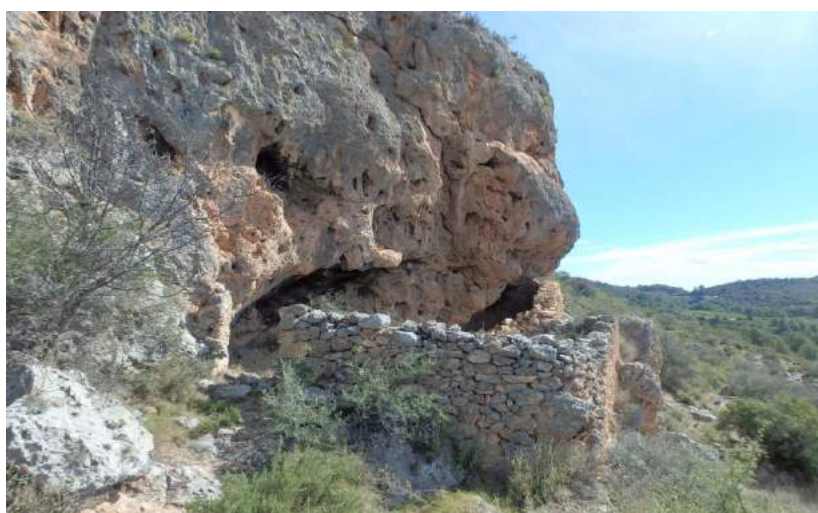
Muro de cerramiento en la cavidad referenciada como PC04
