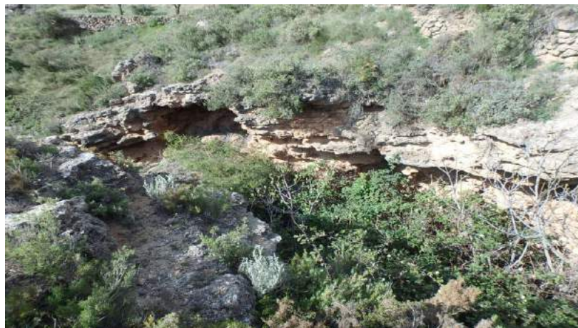
Agujeros y oquedades en el cauce del Hurón cerca del Paso Cuevas
